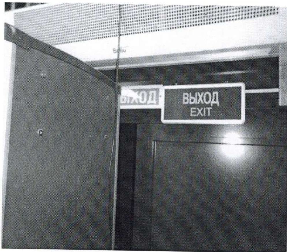
Пути эвакуации – Фото №43
