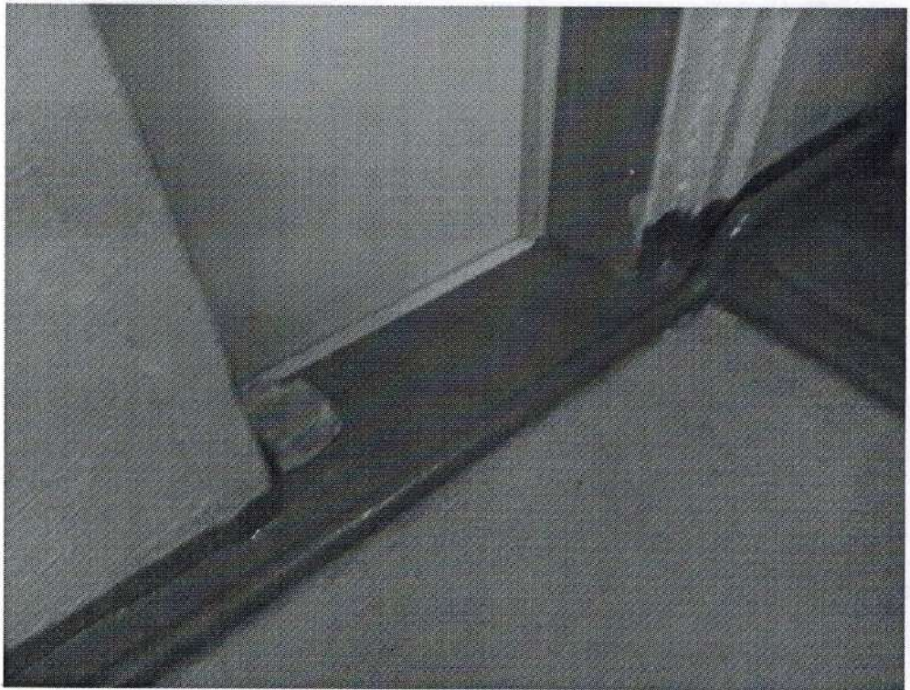
Дверь (на пути эвакуации) – Фото №38
