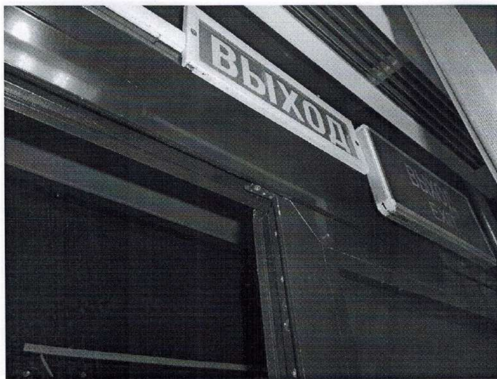
Пути эвакуации – Фото №42
