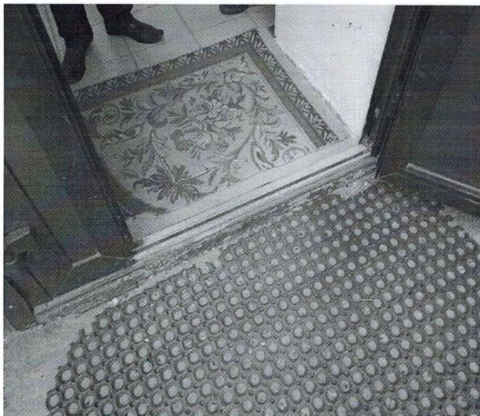
Дверь (на пути эвакуации) – Фото №31
