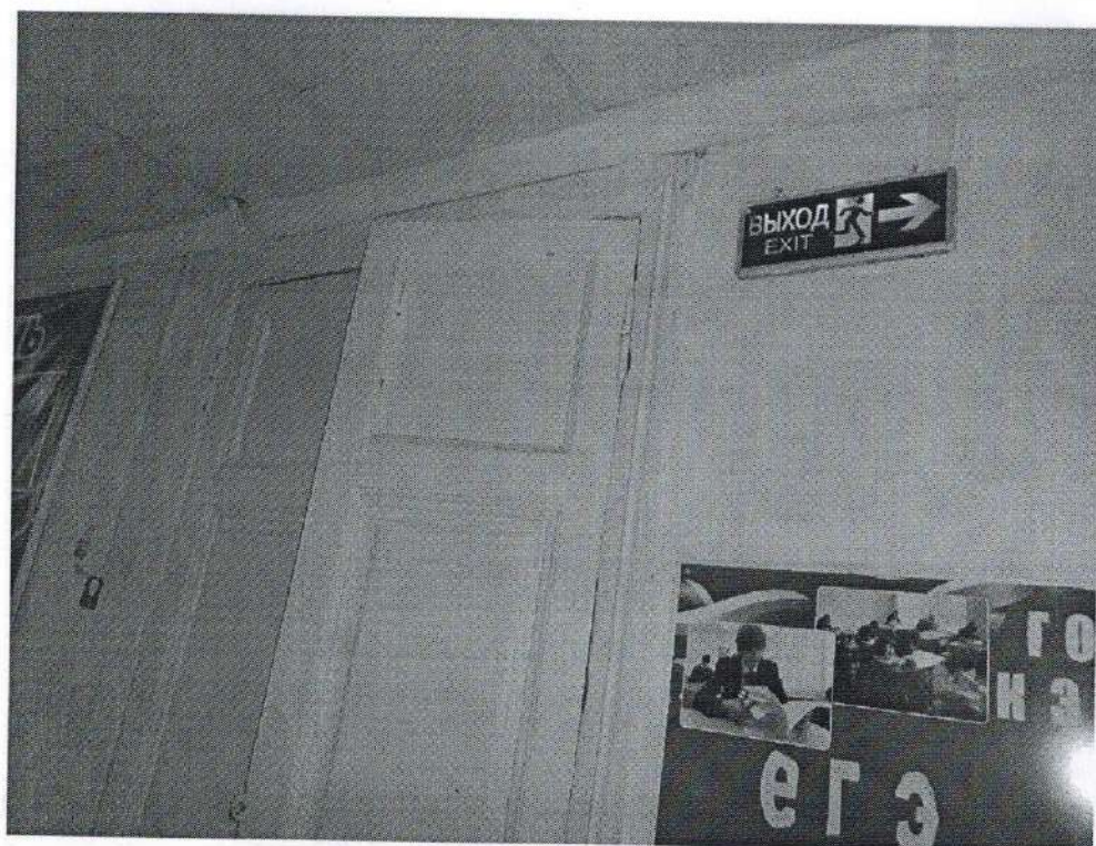
Пути эвакуации – Фото №44
