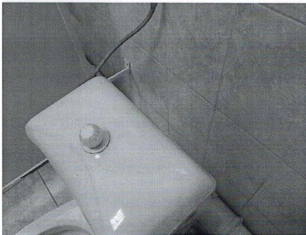
Туалетная комната – Фото №66
