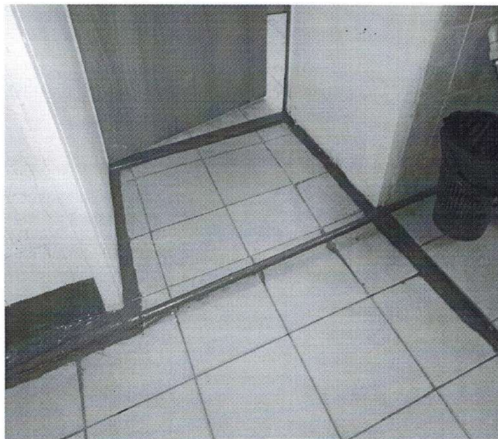
Дверь в туалетную комнату – Фото №59
