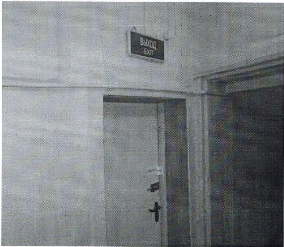
Дверь (на пути эвакуации) – Фото №37
