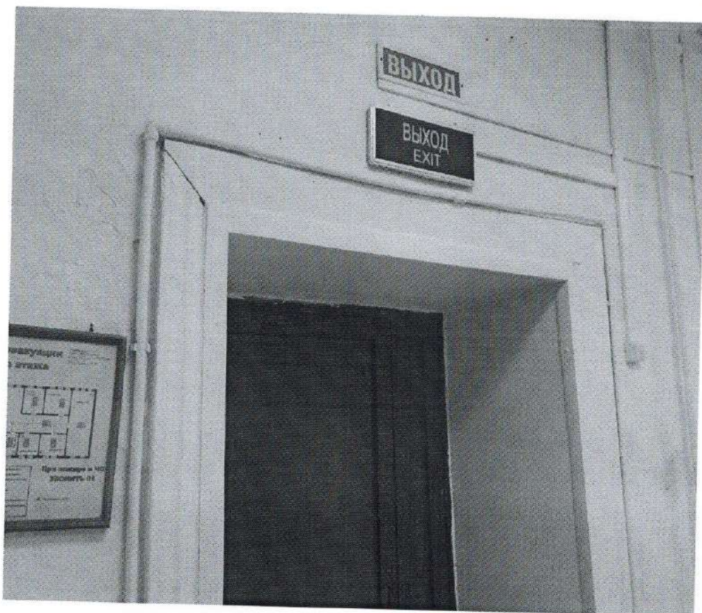
Пути эвакуации – Фото №45
