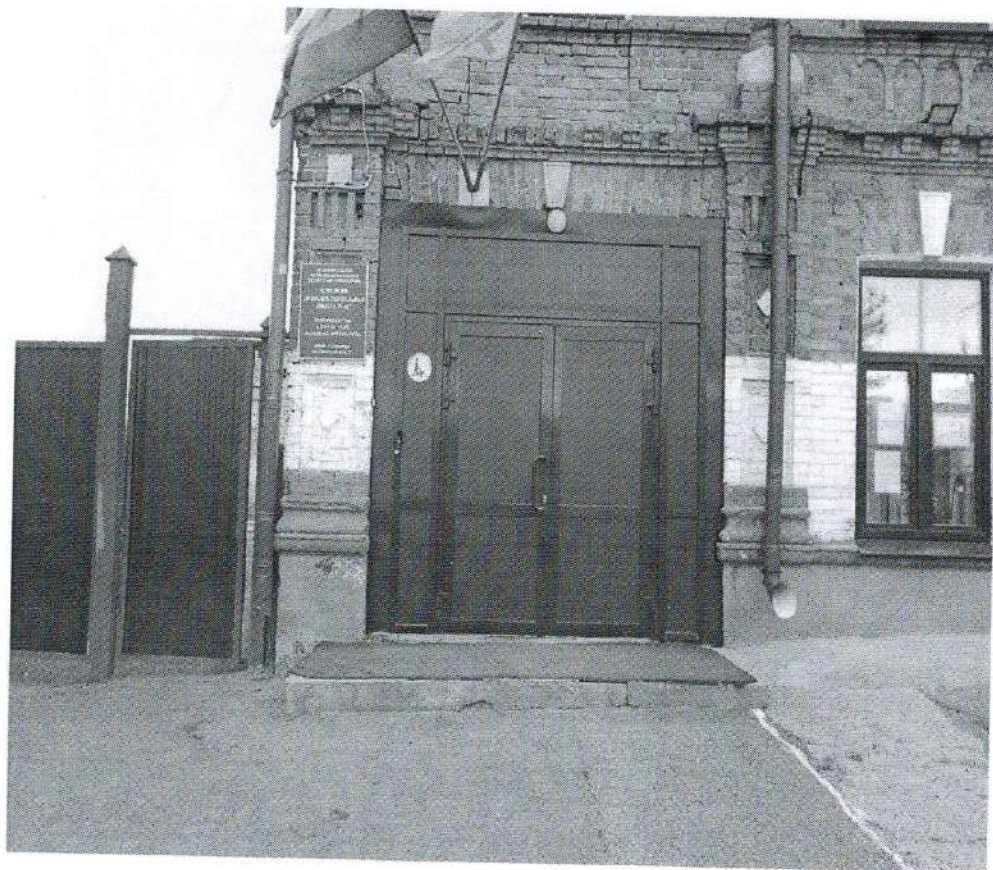
Входная площадка (перед дверью) – Фото №7
