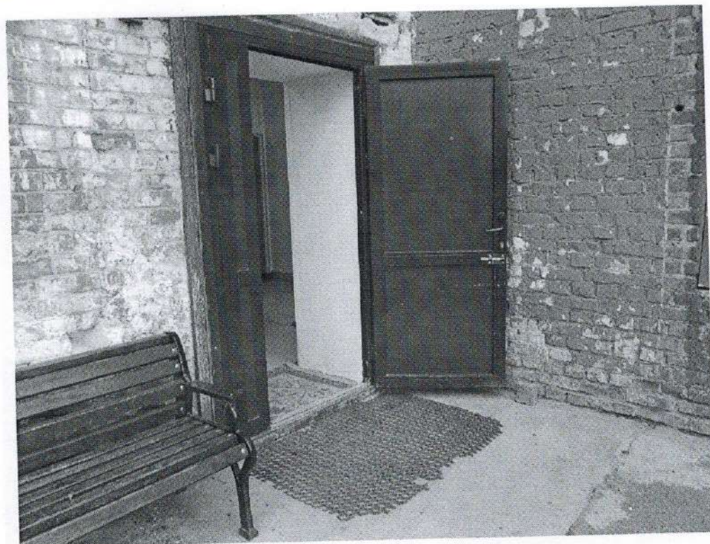
Дверь (на пути эвакуации) – Фото №30
